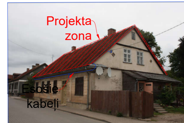
Darbu veikšanas zona no ielas fasādes D puses
